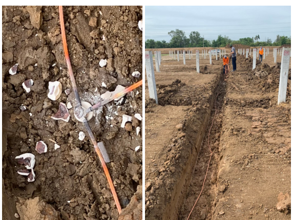
5) การติดตั้งระบบ Grounding
