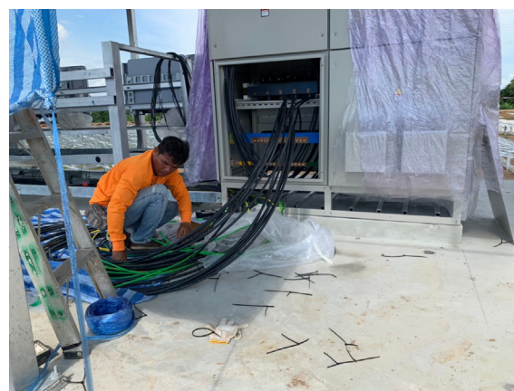
4) การติดตั้งสายไฟ DC และ AC
