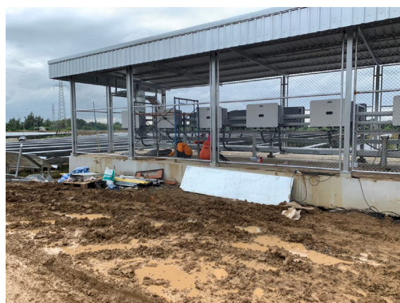
6) การจัดทำ Inverter Station และ Transformer Yard
